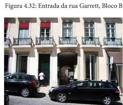
Figura 4.32: Entrada da rua Garret, Bloco B
