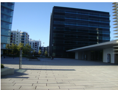
Figura 4.73: Entrada do edifício L Abstracção das fachadas
