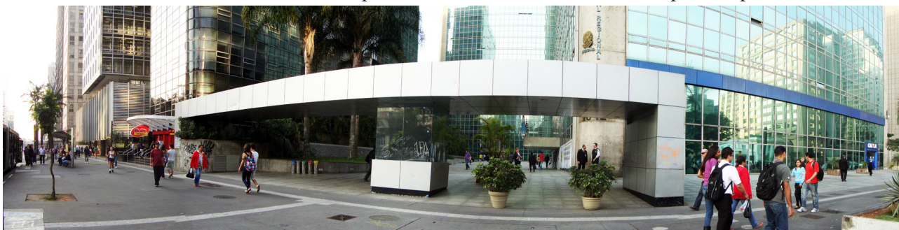
Figura 4.100: Pórtico de entrada Av. Paulista
