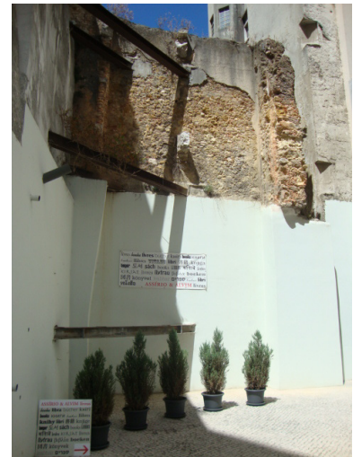
Figura 4.30: Muro no final do percurso do Bloco B
