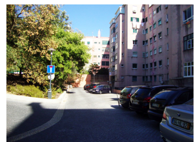
Figura 4.53: Rua sem saída - Quarteirão 2
