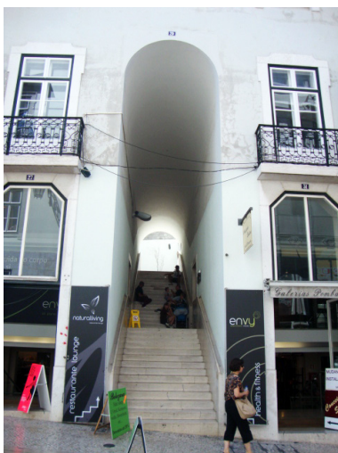
Figura 4.33: Entrada da rua do Carmo, Bloco B
