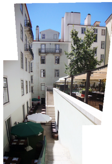
Figura 4.24: Dois patamares, Bloco A
