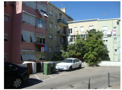
Figura 4.49: Fachadas internas dos edifícios
